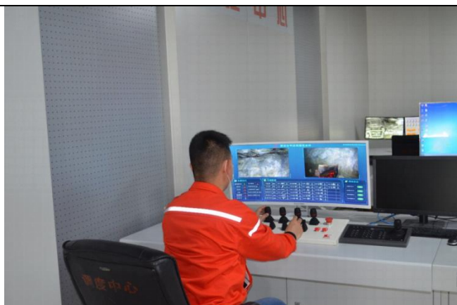
图 3-40 5G 无人化掘进操控台
