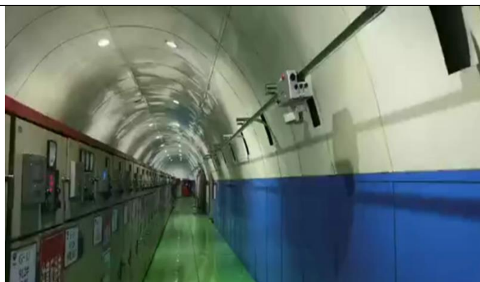
图 3-37 5G AI 机器人机电硐室无人巡检
